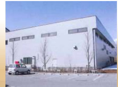
容器包装プラスチック リサイクル施設
