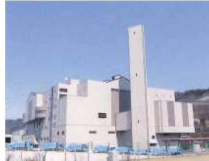
可燃ごみ処理施設
