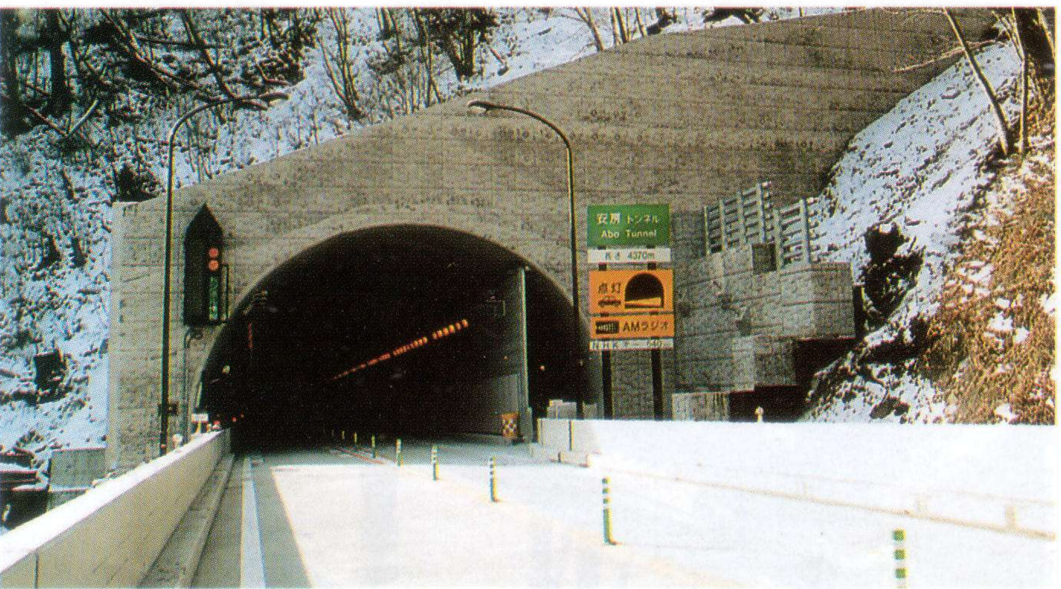
開通した安房トンネル (中の湯側入口)
