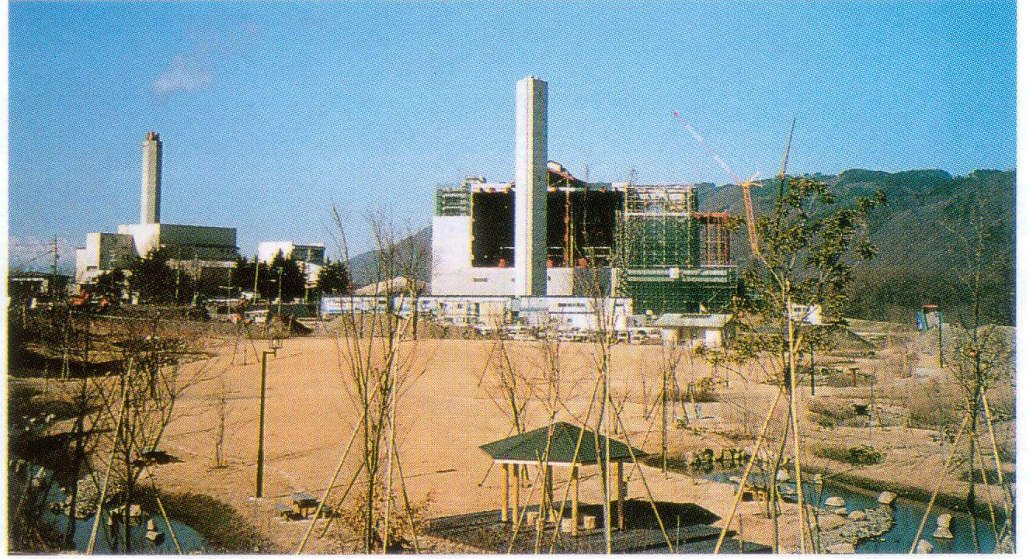
平瀬緑地から見た新焼却プラントと現清掃センター
