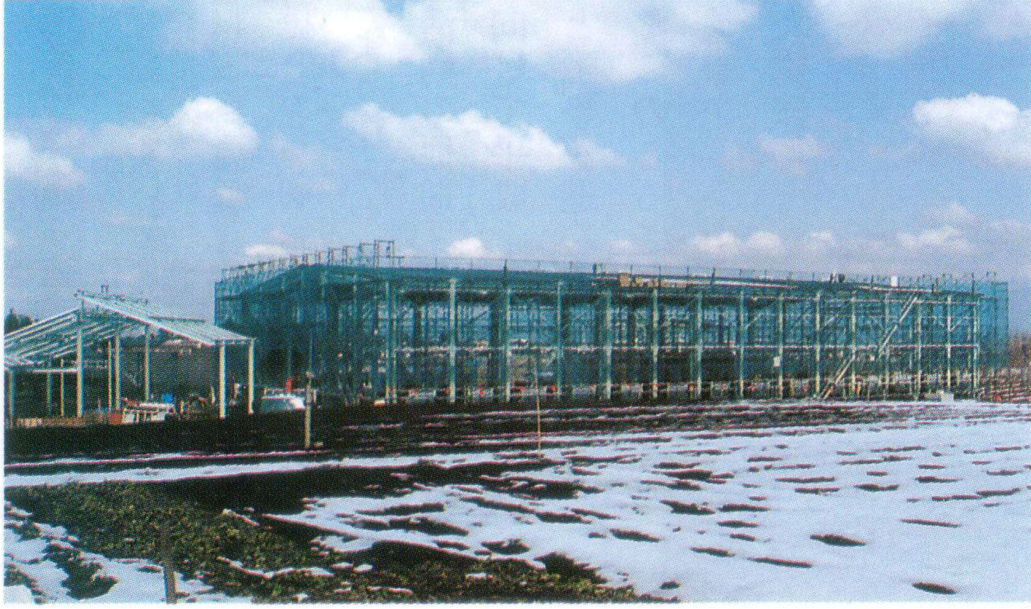
建設中の最終処分場
