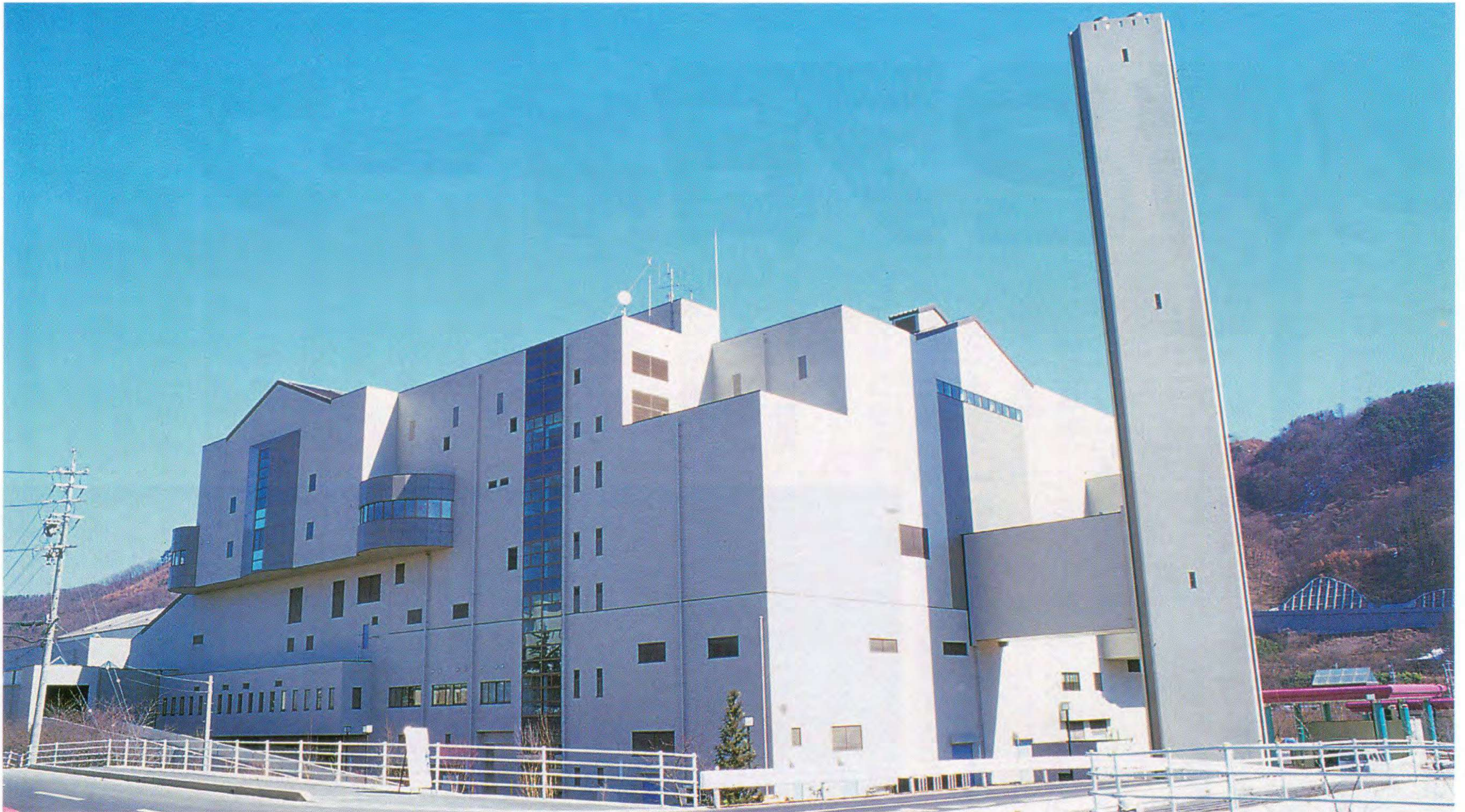
松本クリーンセンター
