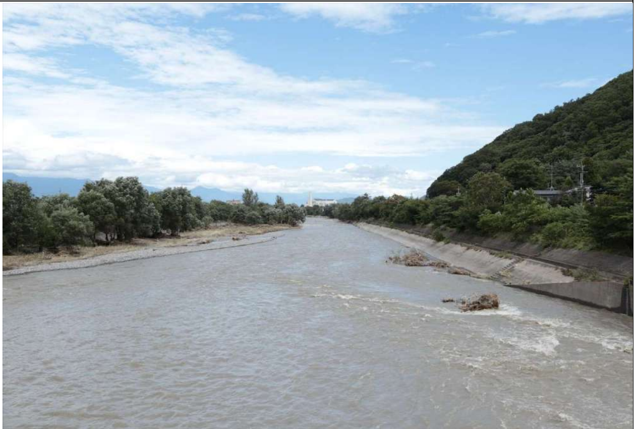
No.2 犬飼新田（南南東方向—1.9km 注 、拾ヶ堰頭首工より）
