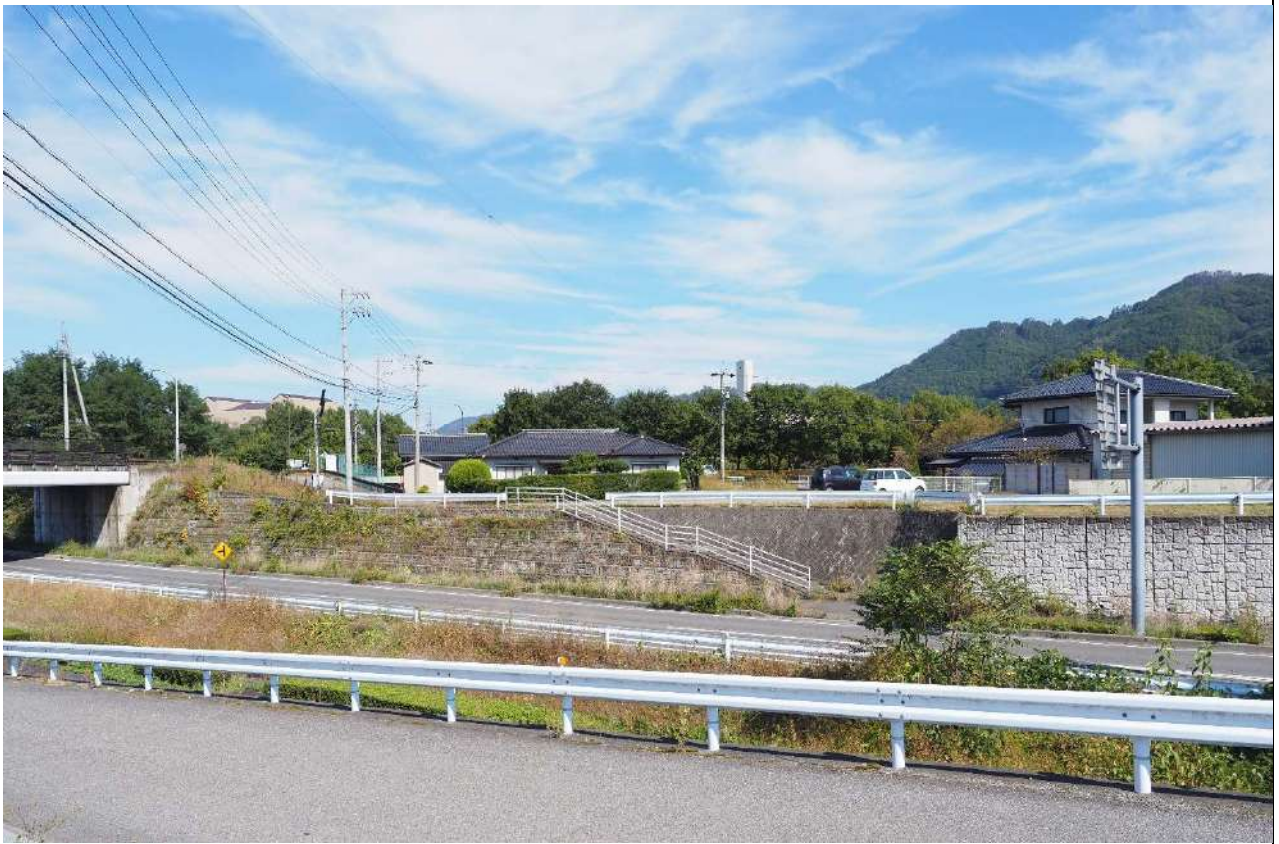
No.5 平瀬川西（南方向一約 0.45km 注) 、道路脇空き地より）
